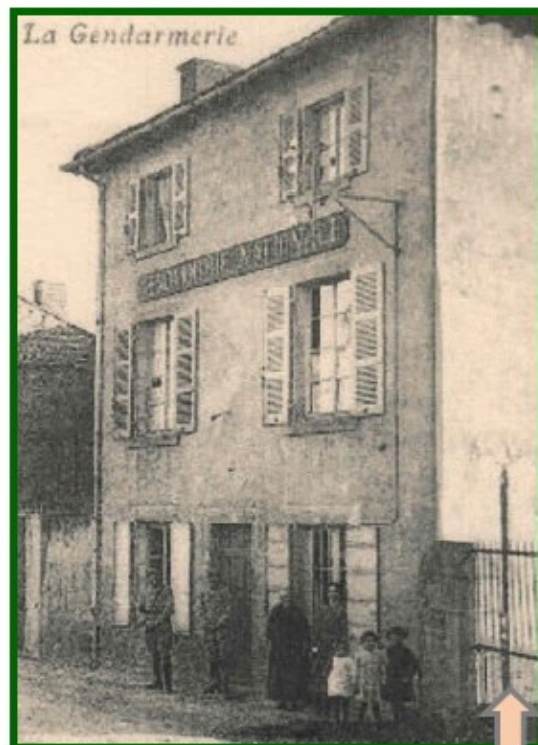
Ce portail ferme actuellement la cour de la Maison de Pays!
