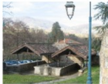
Le lavoir du bd des Aqueducs
